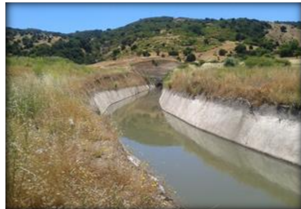
Sector de salida poniente Túnel La Lajuela.
