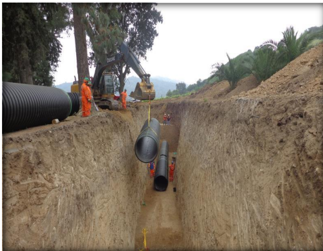
Instalación de tubos de HDPE, Km 1,800.
