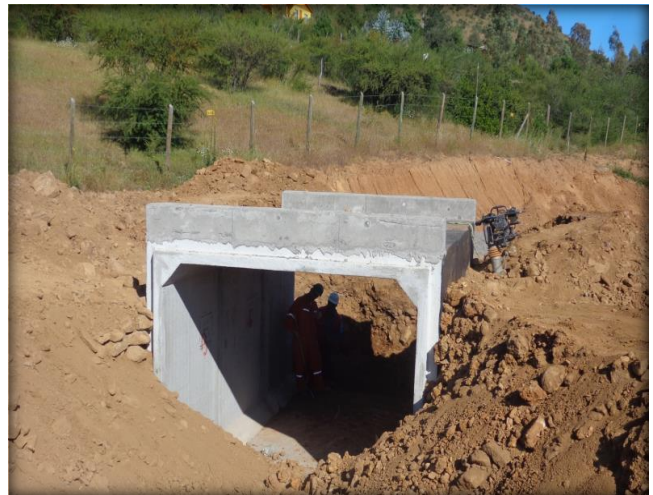
Instalación de cajón para paso predial, Km 16,390
