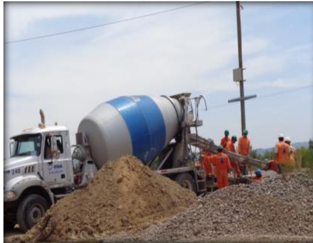
Hormigonado de cámara de Bogaris.
