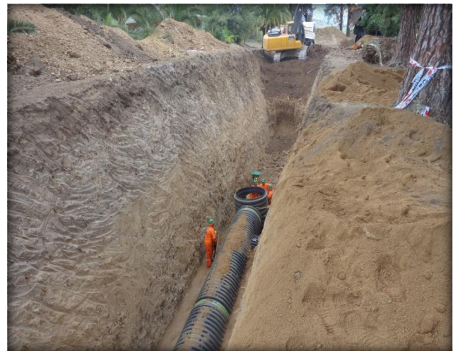
Colocación de cámara de inspección.
