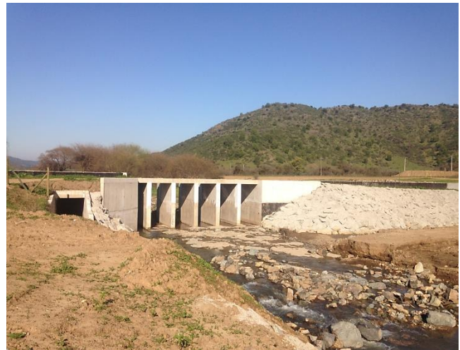
Bocatoma Canal Norte Unificado, barrera frontal.
